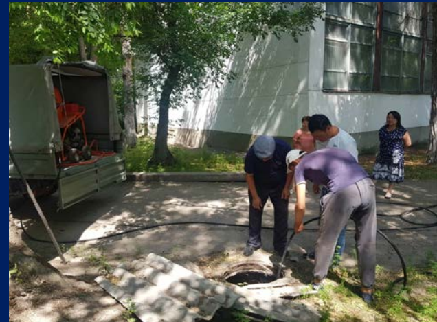
Процесс промывки канализации
