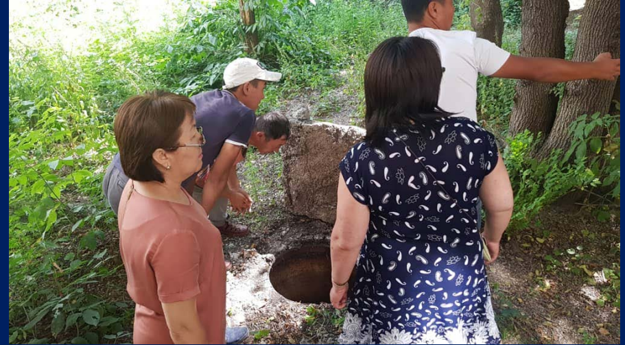
Осмотр состояния канализации с представителями МП Зеленхоз и школы
